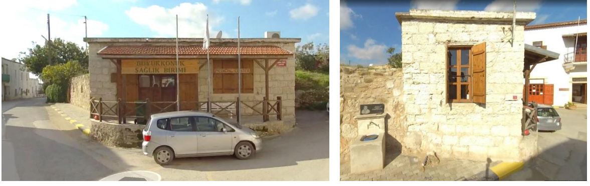
Resim 5: Mevcut Aile Sağlığı Merkezi Binası (URL 8, 2022)
