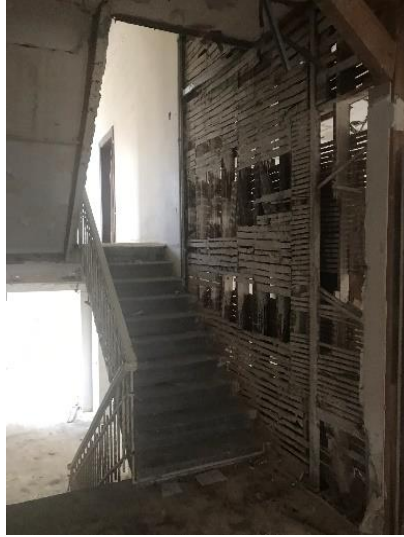
Resim3: Birinci katta yer alan ahşap çitalı ara duvarlar
