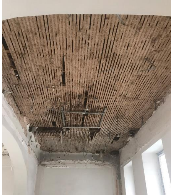
Resim 2: Zemin katın ahşap tavan kaplaması
