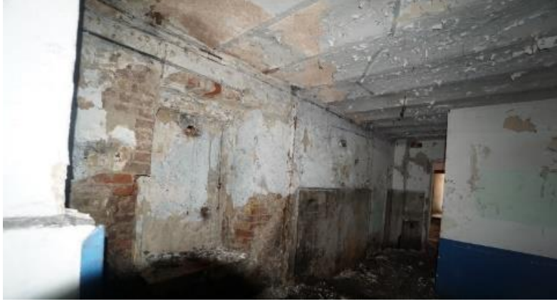
Resim 1: Bodrum katın kağır duvarları
