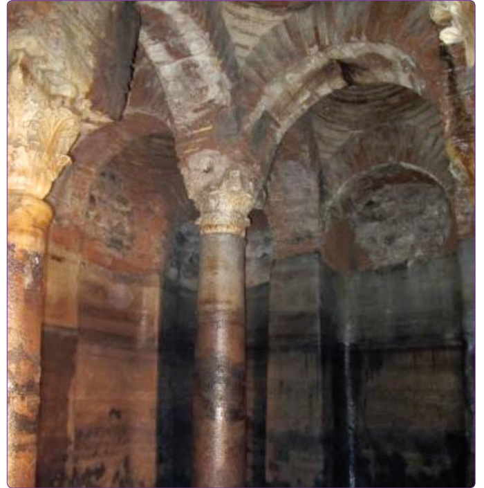
Şekil 6. Sarnıç, 2012 (Kaynak: MDM Mimarlık Ltd.).
