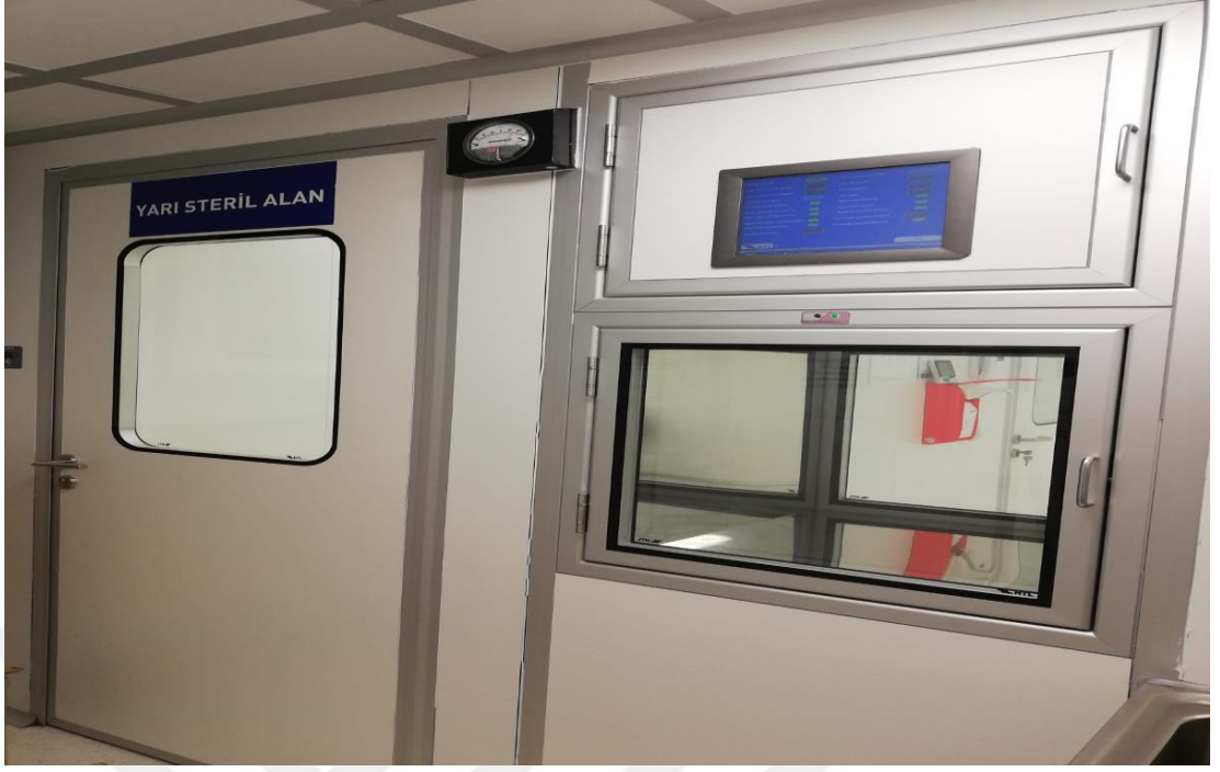
Resim 5-4 Malzeme sterilizasyonu için pass-box, oda içi teknik gösterge paneli ve yarı steril alana giriş (Giriş-1) (26.03.2020)
